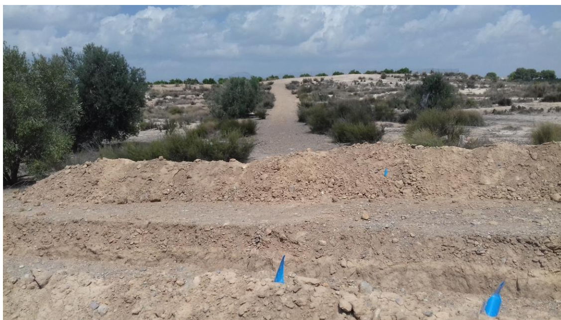
Fotos de la ejecución de la tubería de los regantes tomada el 5-9-2018.
